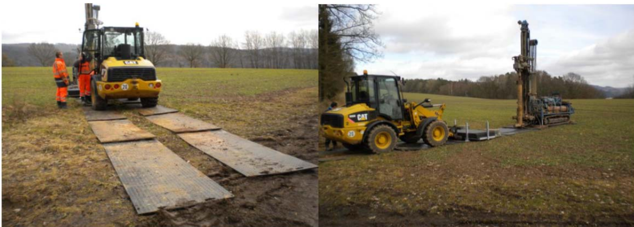
Einsatz von Bodenschutzplatten
