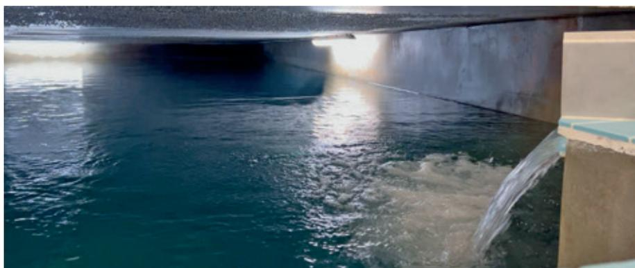
Blick in das Innere eines der Hochbehälter zur Wasserspeicherung
