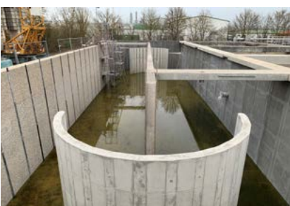
Die Kläranlage während den (Beton-)Sanierungsarbeiten.
